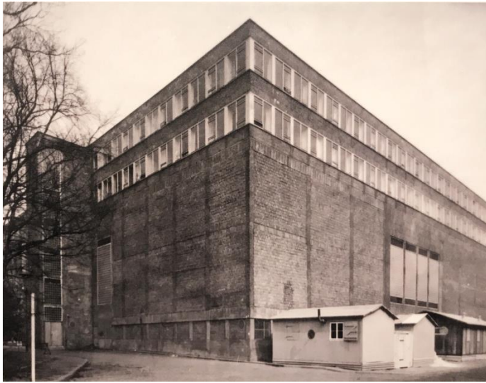
Magazinbau kurz nach Fertigstellung (1950er Jahre). Gut zu erkennen ist das Mischmauerwerk der Ausfachungen.
