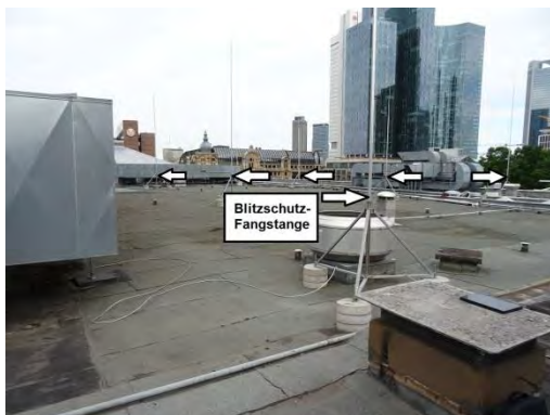
Dach Ssp: Blitzschutz Fangstangen
