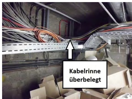
UG Oper, Sanitärlager 01-98-08-022, Überbelegung AV-Kabeltrasse
