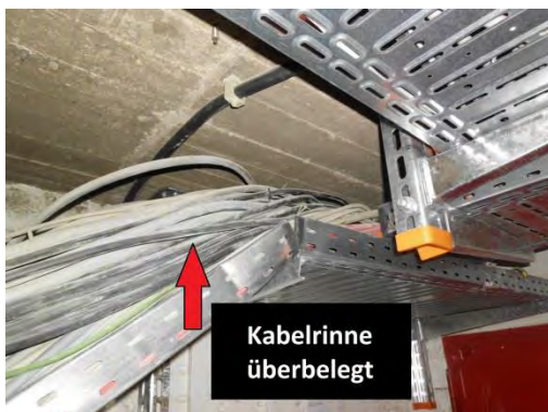
UG Ssp Flur am TRH 1, Überbelegung AV-Kabeltrasse
