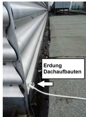
Dach Oper: Erdung Dachaufbauten
